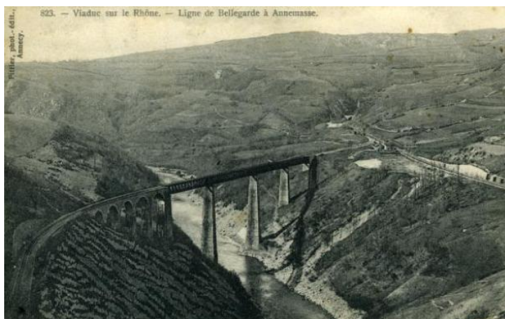
1 er viaduc de Longeray - 1881
