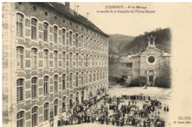
Bâtiment de l'usine et son ancienne chapelle
